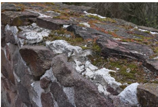
Mauerkrone Burgruine Hohnstein
